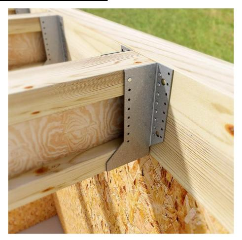
**Método:** El estribo debe cubrir la altura total de la viga.
